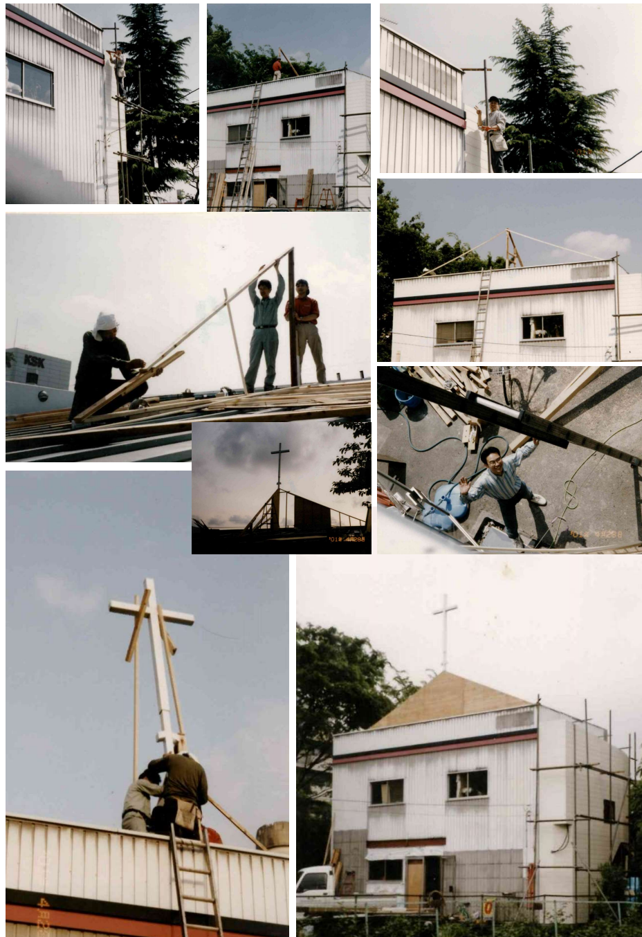
たんぼぼ教会アルバムより「十字架設置工事」2001年4月28日
